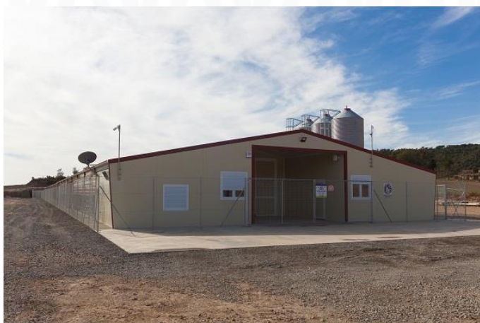
Paviment perimetral de l'àrea d'una nau.
