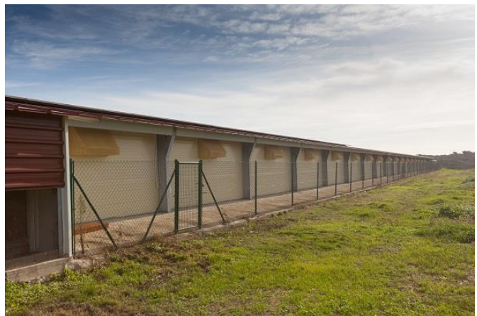
Pavimentació perimetral de l'àrea externa del galliner per pollastres d'engreix
