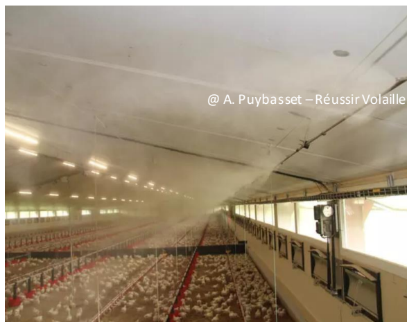
La nebulització en la nau millorarà el benestar de les aus durant els períodes calorosos
