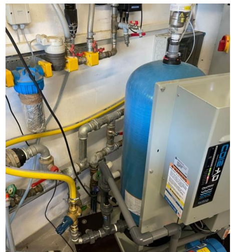
Fig. 2: El concentrador de ozono y la bomba se conectan fácilmente al circuito. (© O 3 Tech GmbH).
